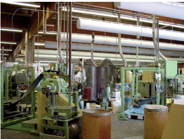
1. Toepassing van flexibele luchtslangen zijn te vinden in bijvoorbeeld productieruimten.
