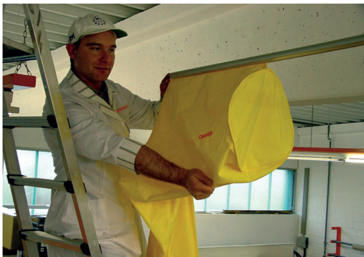
2. Montage van de flexibele luchtslang kan eenvoudig plaatshebben.
