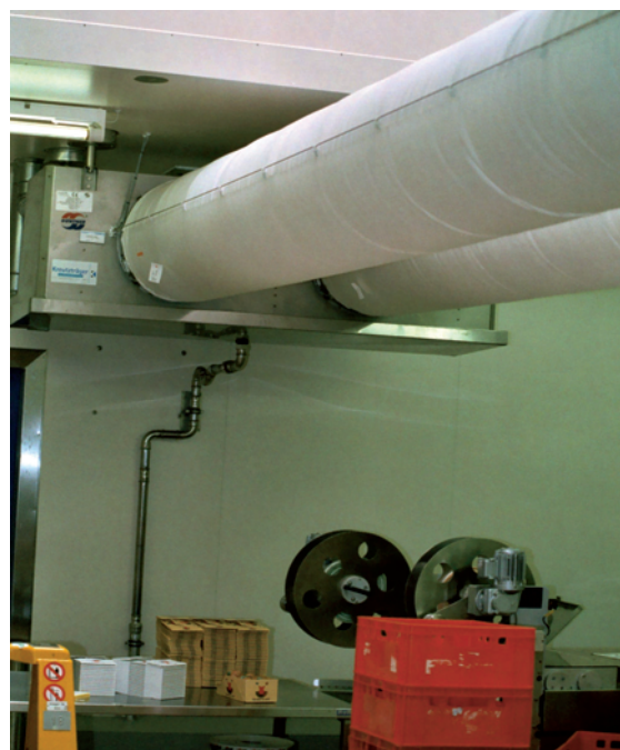
3. Luchtverdeelsslange van textiel zijn te combineren met metalen kanalen.
